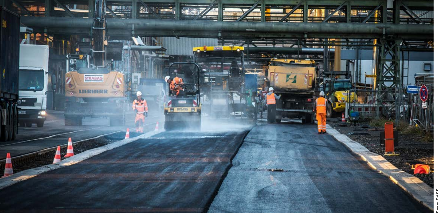
Bild 1: Einbau vom Reaktivmodifizierten Asphalt auf dem Werksgelände der Basf in Ludwigshafen
